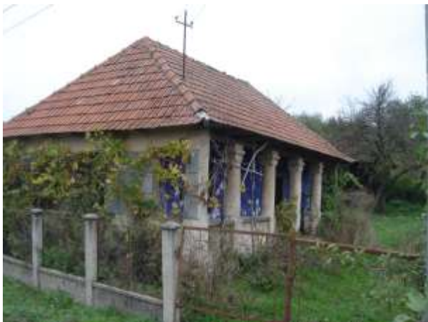
Stâlpi masivi de zidărie la nr. 152
