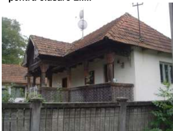
Cuceu, la nr. .. o casă de gospodar, cu târnaț și foișor cu decoruri din lemn traforat; din păcate ferestrele la stradă au fost înlocuite în mod nefericit cu ferestre tip bloc.
