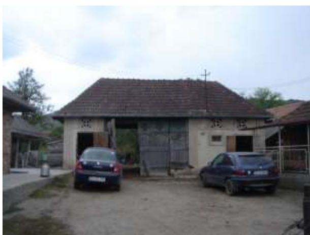
Anexă decorată cu șură și grajd la nr. 25
