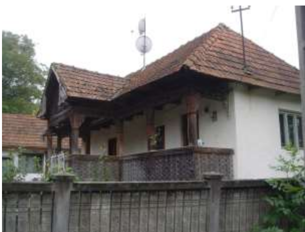
Casă cu târnaț și foisor din lemn cu traforuri elaborate. Ferestre originare cu excepția fațadei de la stradă
