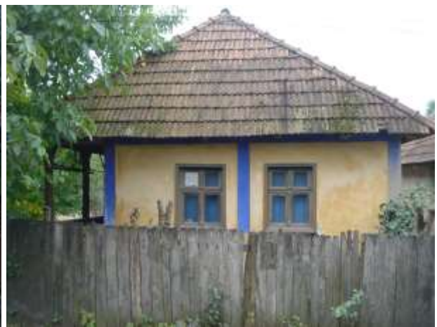
Casă cu structură din lemn și tâmplării originale
