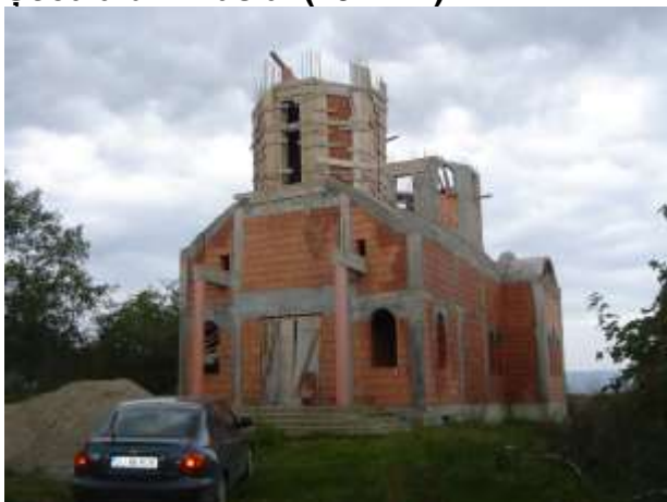
Biserică ortodoxă nouă în construcție
