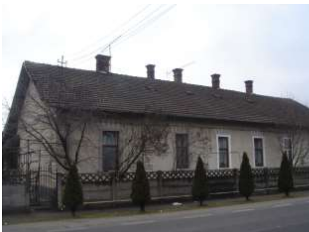
Construcții vechi din apropierea gării Str. 22 Decembrie 1989 nr. 10
