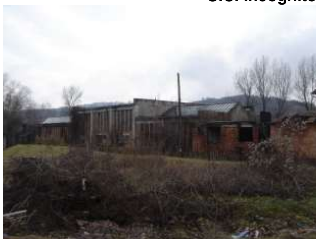
Clădiri cu foste funcțiuni industriale, își așteaptă pentru reabilitare investitorii.
