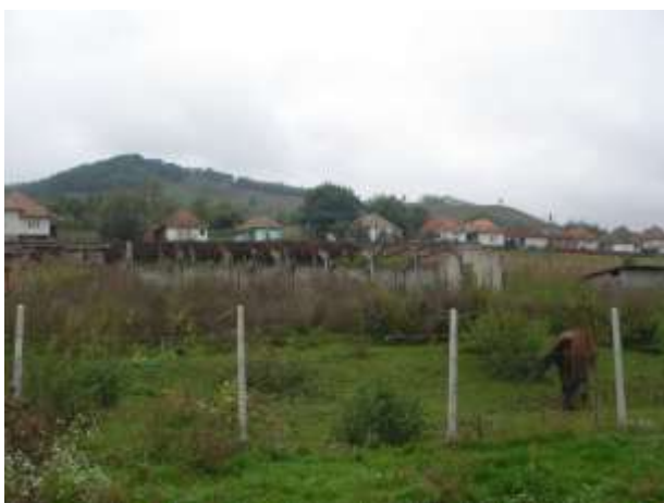
Ruinele fostelor grajduri CAP se cer refuncționalizate.
