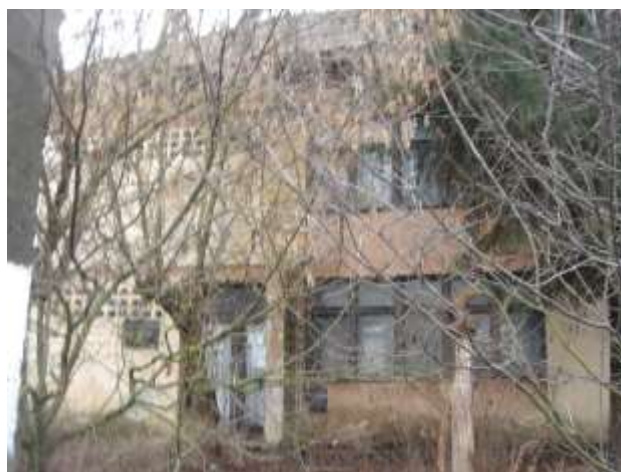
Fostul dispensar medical al lucrătorilor CFR se cere reabilitat.
